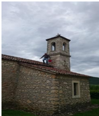
屋根が破損していたため修復するおじさん。
