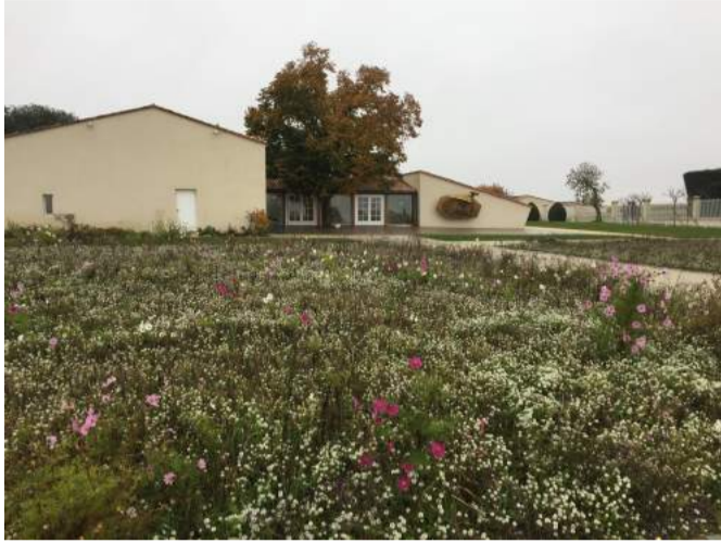
4年前に改装されたばかりの平屋のオフィススペース。大きな駐車場が併設され、オフィス前には庭園がありました。
