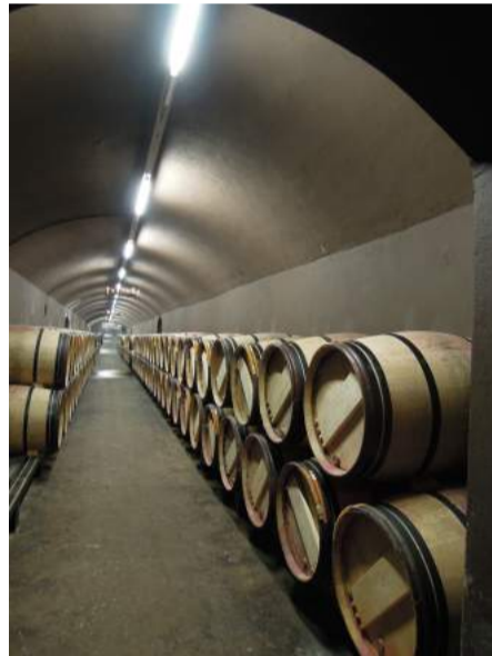
横 25m 奥行き 100m の巨大樽貯蔵室。改装前から存在する空間。昔の技術でこの広さをカーブ状に作るには至難の技だったそう。
